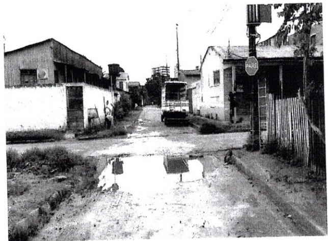
FOTO 04 – Instalação de placa (PARADA OBRIGATORIA)
