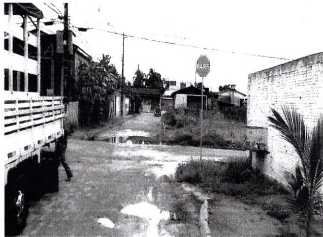
FOTO 06 – Instalação de placa (PARADA OBRIGATORIA)
