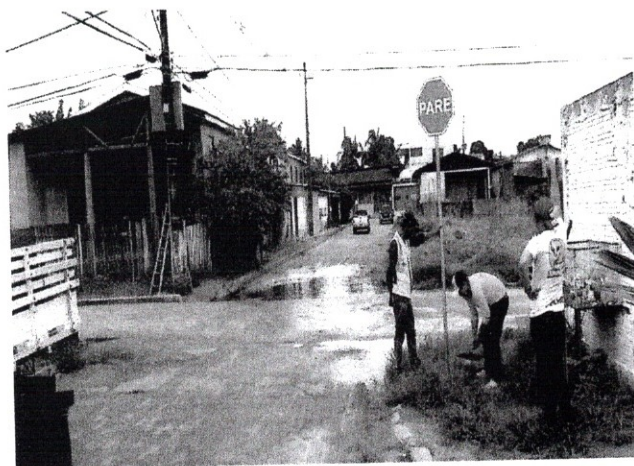
FOTO 03 – Instalação de placa (PARADA OBRIGATORIA)
