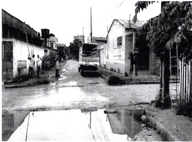
FOTO 05 – Instalação de placa (PARADA OBRIGATORIA)
