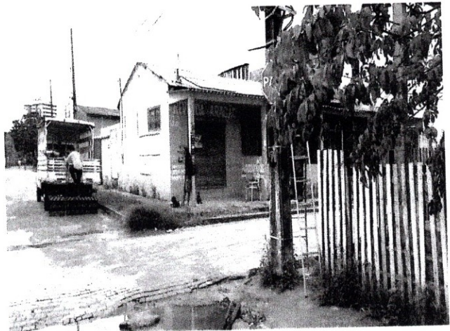
FOTO 02 – Instalação de placa (PARADA OBRIGATORIA)
