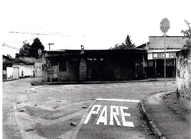
FOTO 04 – Revitalização de sinalização Retenção com nome PARE
