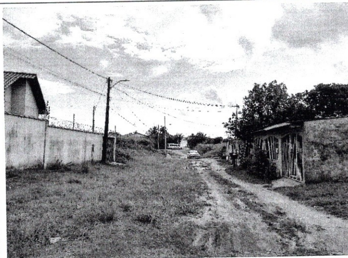
FOTO 02 – VIA NÃO POSSUI SINALIZAÇÃO VERTICAL.
