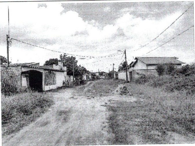
FOTO 01 – RUA COPAÍBA NÃO POSSUI CALÇAMENTO NEM PAVIMENTAÇÃO ASFÁLTICA.
