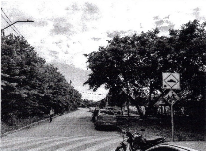
FOTO 03 – SINALIZAÇÃO VERTICAL EXISTENTE NO LOCAL.
