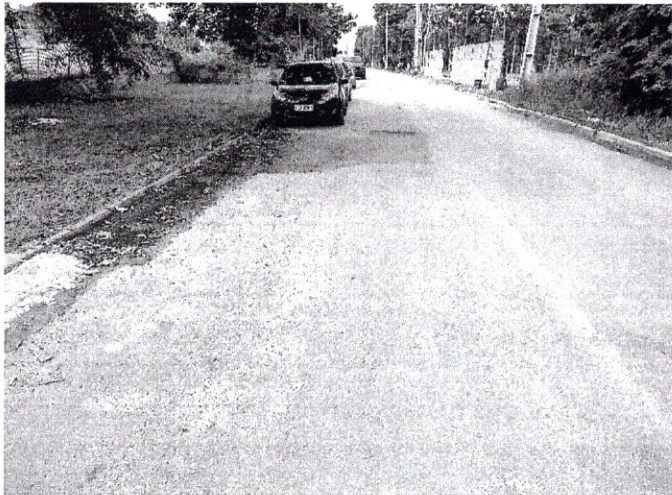
FOTO 01 – TRECHO DA AV. DURVAL CAMILO APRESENTA BOA PAVIMENTAÇÃO ASFÁLTICA.
