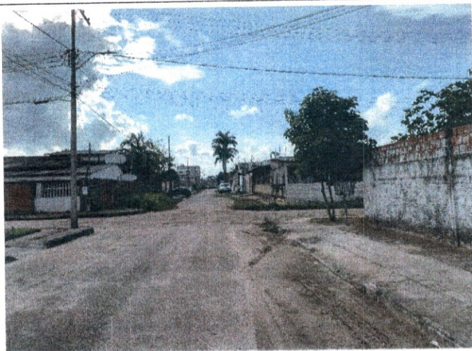
FOTO 01 – VIA SEM SINALIZAÇÃO HORIZONTAL OU VERTICAL.
