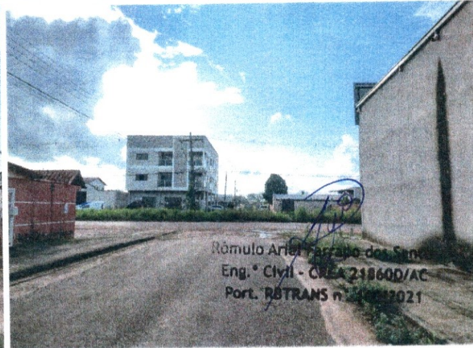
FOTO 04 – FALTA DE SINALIZAÇÃO HORIZONTAL E VERTICAL.
