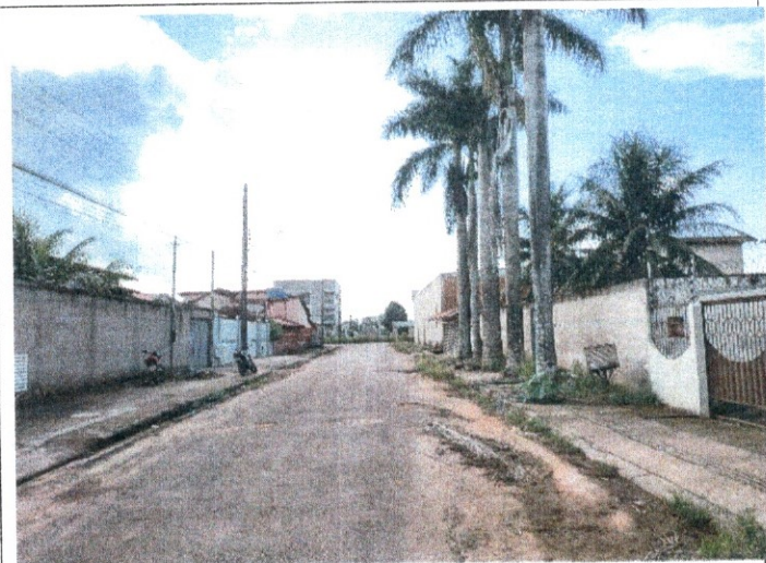
FOTO 03 – AUSÊNCIA DE SINALIZAÇÃO EM TODA A EXTENSÃO.
