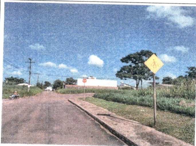
FOTO 01 – PLACAS DE SINALIZAÇÃO EXISTENTES NA VIA.
