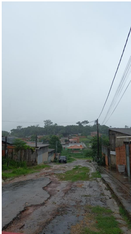
Figura 1 – Pavimentação com buracos e esgoto cheio(entupido).
