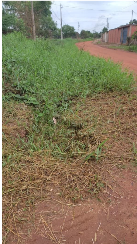
Figura 1 – Pavimentação com buracos e esgoto cheio(entupido).
