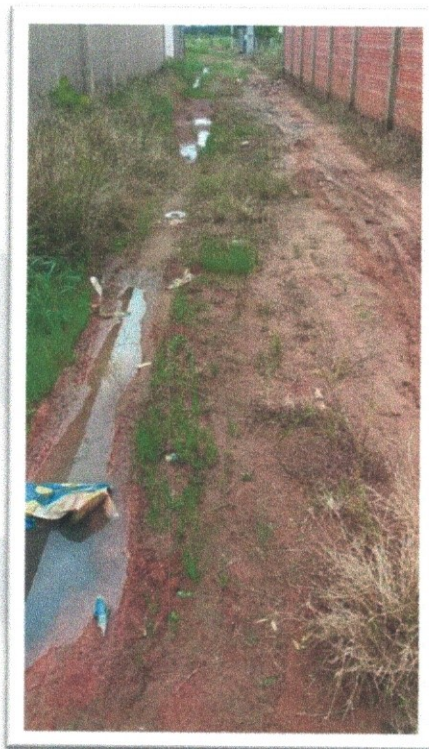
Figura 2-Pavimentação de Via Pública.
