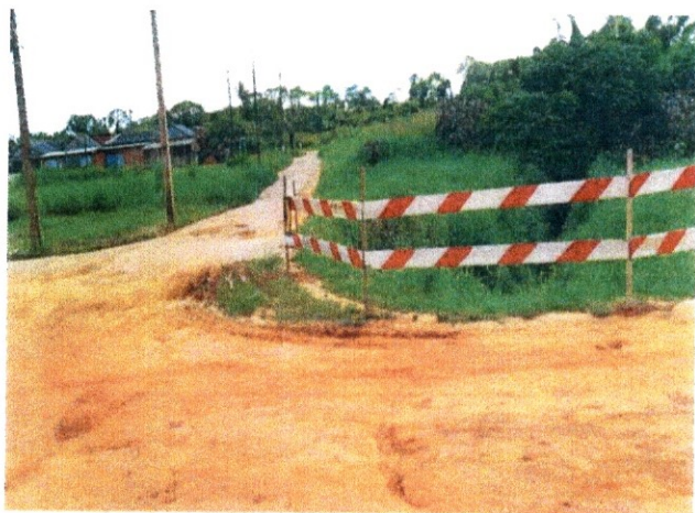
FOTO 03 – Instalação de interdição com barreiras fixas
