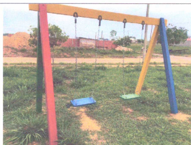
Figura 4 – Balanço – serviço concluído
