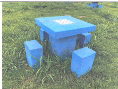
Figura 1 – Mesa de xadrez- serviço concluído
