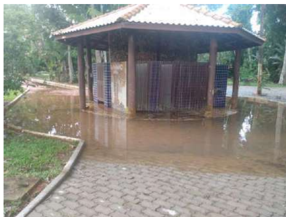
Figura 121. Registro dos problemas de drenagem e entupimento dos vasos sanitários do banheiro público do Parque Ambiental Chico Mendes
