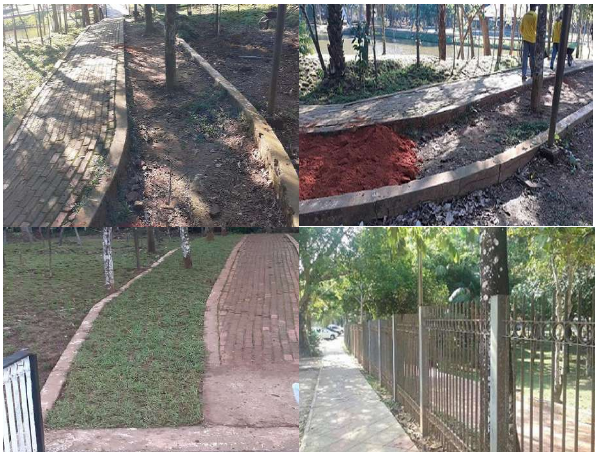
Figura 107. Reparo, troca de tijolos na pista e plantio de grama
