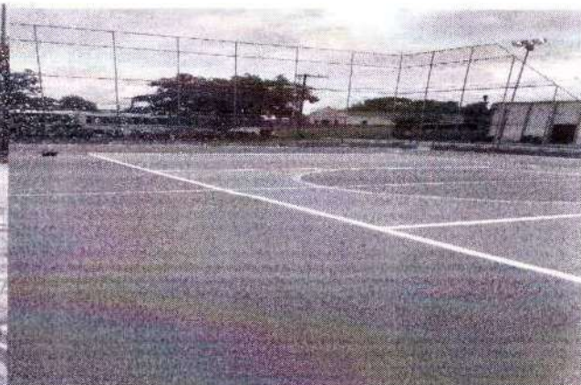
foto 106 – execução da pintura da quadra
