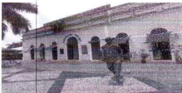
Foto 1 – vista frontal do mercado antes da reforma
