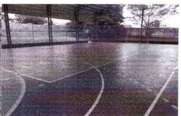
Foto: 50 – pintura do poste e mureta do quadro
