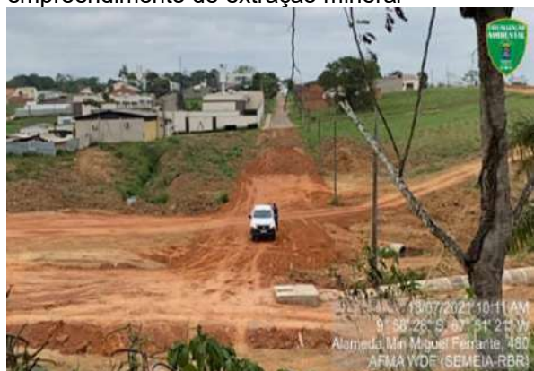
Figura 54. Fiscalização em áreas de loteamentos
