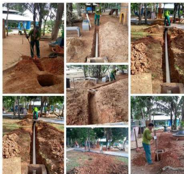
Figura 132. Registro da construção do sistema de escoamento dos resíduos dos banheiros públicos no Parque Ambiental Chico Mendes
