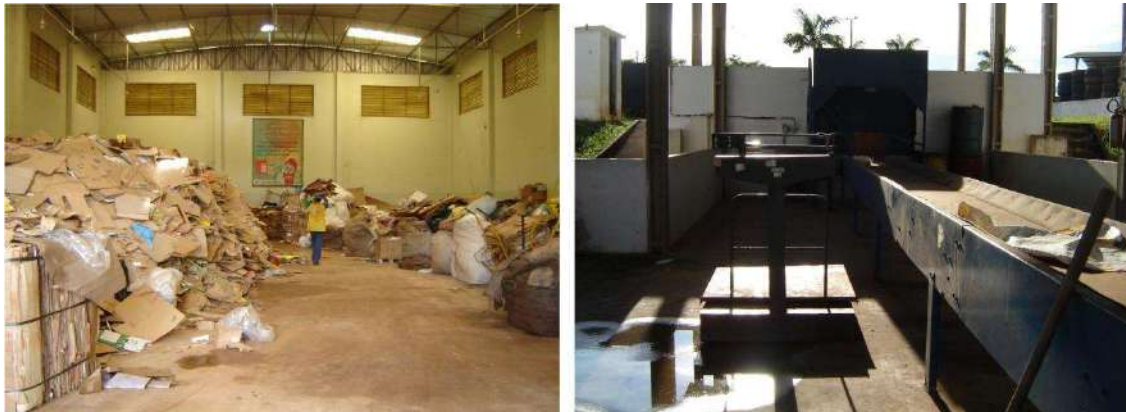
Figura 7 – Unidades de Triagem de RSD Secos (Catar e UTRE).
