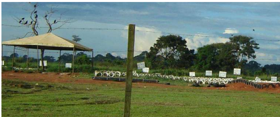
Figura 23 – Valas sépticas localizadas na UTRE.
