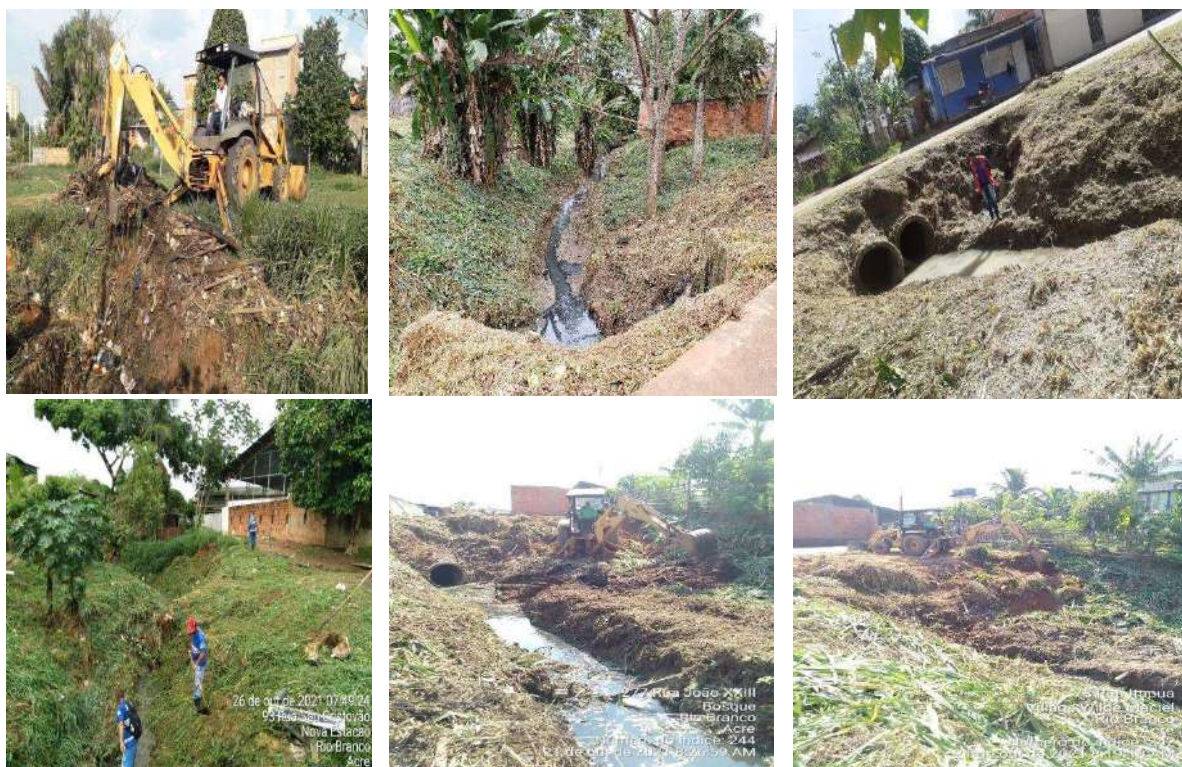
Figura 3 – Desobstrução mecanizada nas margens e nos leitos de córregos
