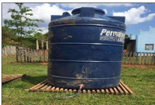
Caixa d'água de 5.000 litros pronta para abastecimento
