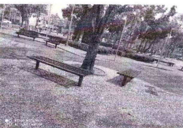
Foto 42 – Execução Das Peças De Madeira E Pintura
