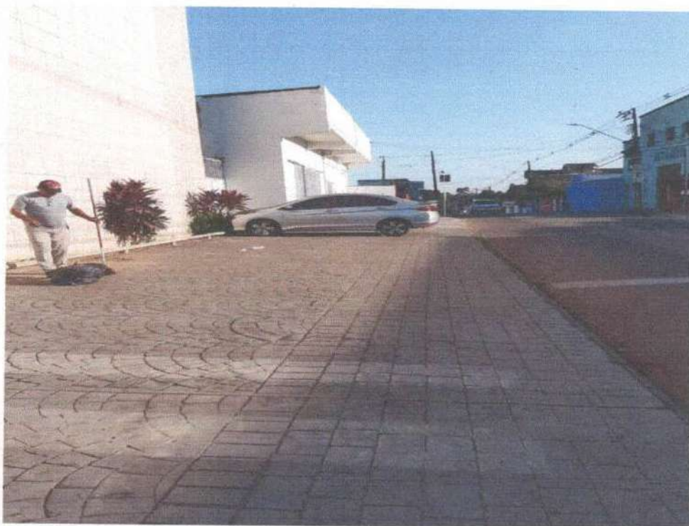
Foto 8 – Calçada do prédio sede da SEGATI antes da reforma
