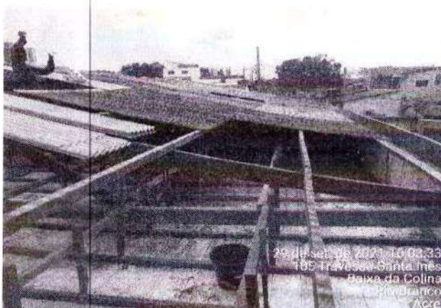
Foto 03 - Remoção De Telhas (Arquivo Seinfra)
