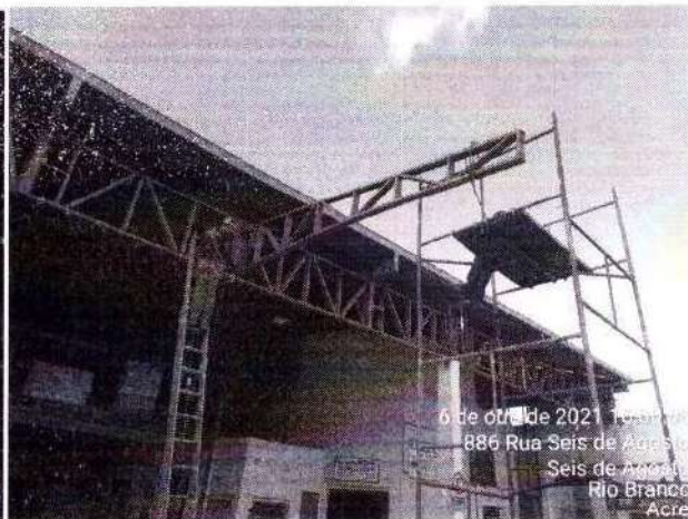
Foto 26- Remoção De Tesoura Metálica Mercado 06 De Agosto
