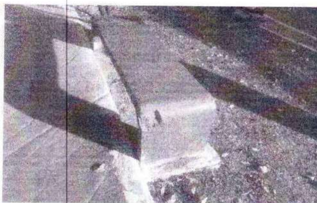
Foto 23 – banco antes da reforma
