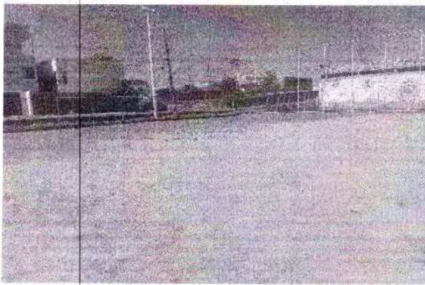
Foto 15 –alambrado antes da reforma
