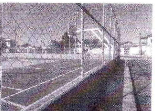
foto 36 – alambrado e pintura da mureta
