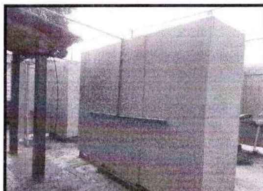
Figura 8 – Pintura Banheiros Coletivos
