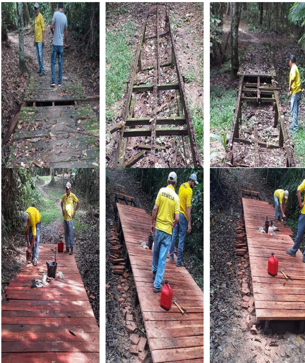
Figura 109. Construção de 2 pontes na trilha
