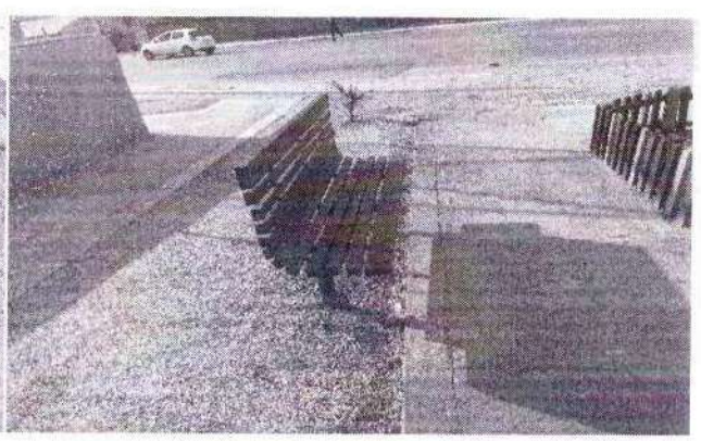
foto 76 – reforma do banco da PRAÇA
