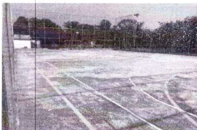
Foto 105 – quadra antes da reforma
