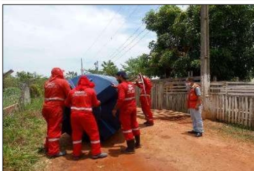
Colocação da caixa d'água no terreno
