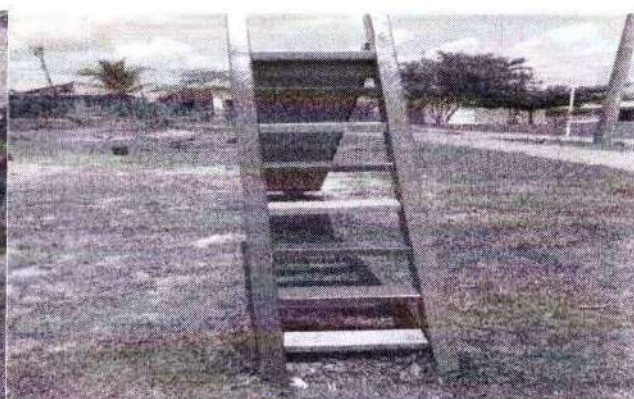
foto 126 – reforma e pintura do parque
