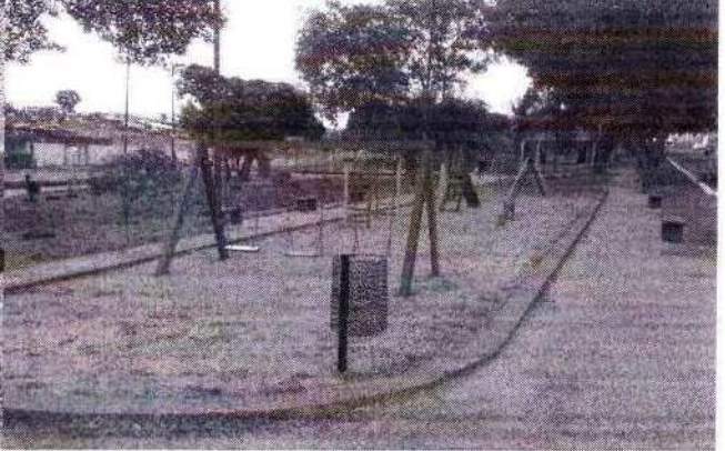
foto 64 – execução da pintura do parquinho
