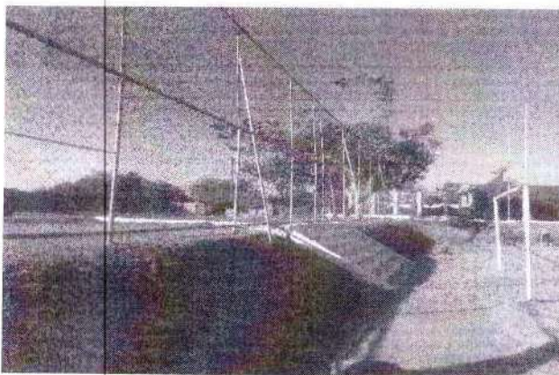
Foto 27 –alambrado antes da reforma
