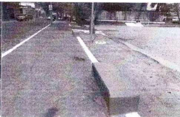
foto 24 – execução da pintura dos bancos
