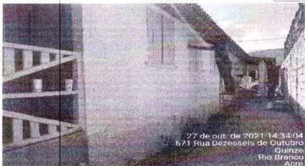
Foto 19 - pintura de esquadrias de madeira (centro cultural Nenem Somba)
