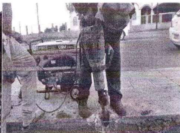
Foto 28 - Demolição De Estrutura De Concreto (Muro)
