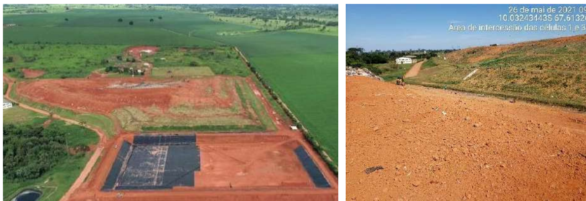
Figura 142. Operação da 2ª etapa da 3ª fase da célula de aterro sanitário de Rio Branco
