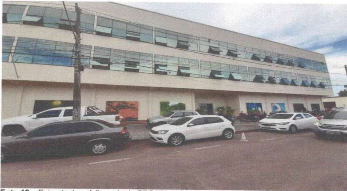
Foto 10 – Faixada do prédio sede da SEGATI após reforma
