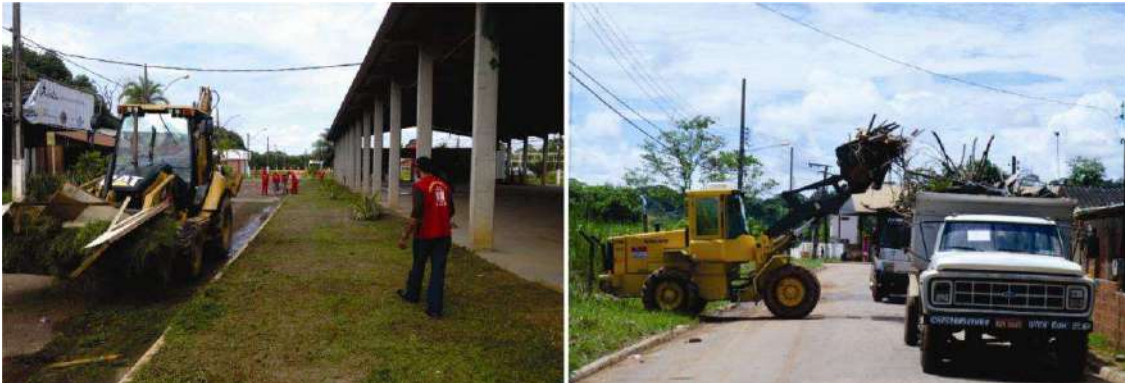
Figura 10 – Serviços executados na “Ação de Inverno”.
