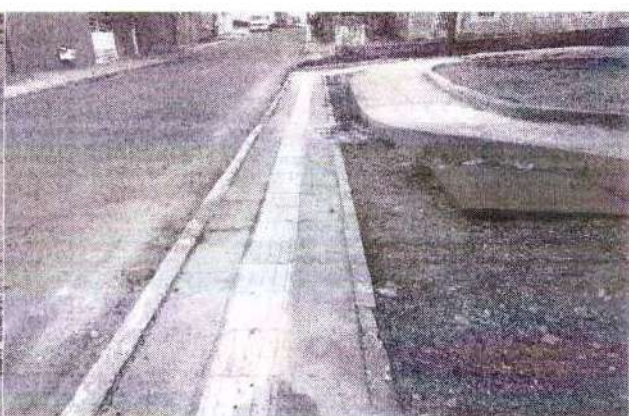
foto 46 – execução da calçada de pedestre
