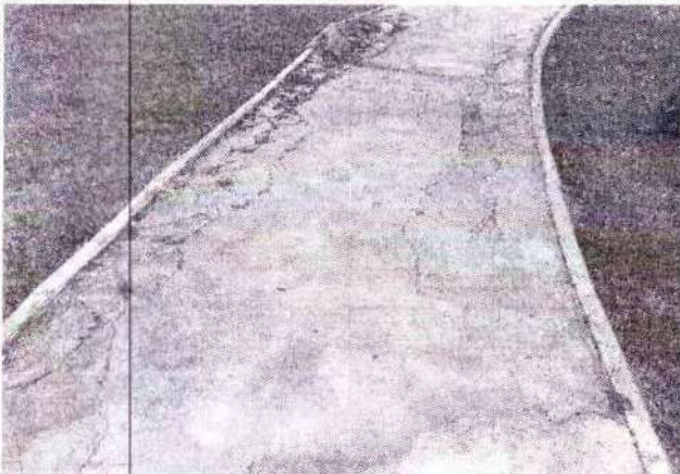
Foto 55– calçada antes da reforma
