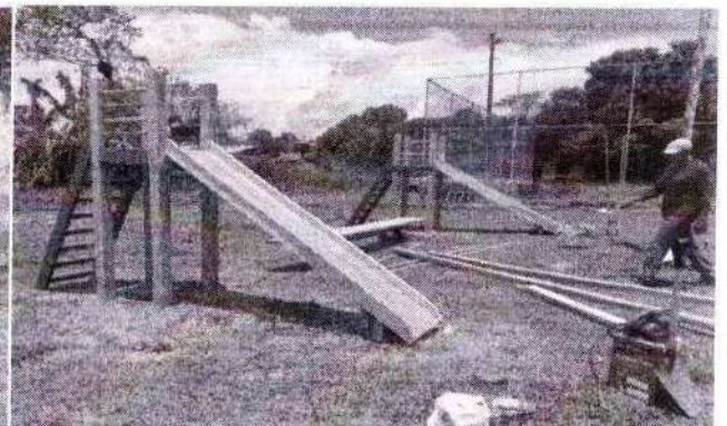
foto 120 – reforma e pintura do parquinho
