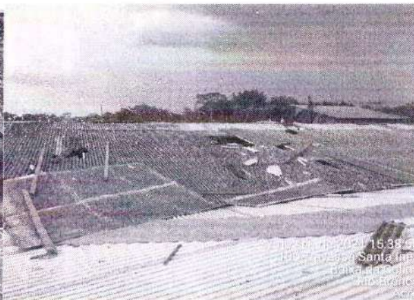
Foto 02 - Remoção De Telhas (Arquivo Seinfra)
