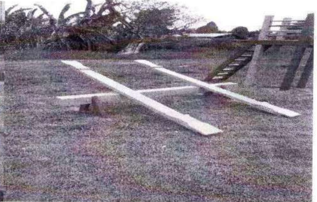
foto 118 – reforma e pintura do parquinho
