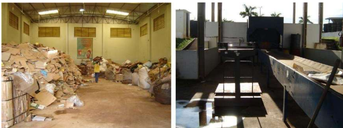
Figura 19 – Galpão da Catar e área de triagem na UTRE.
