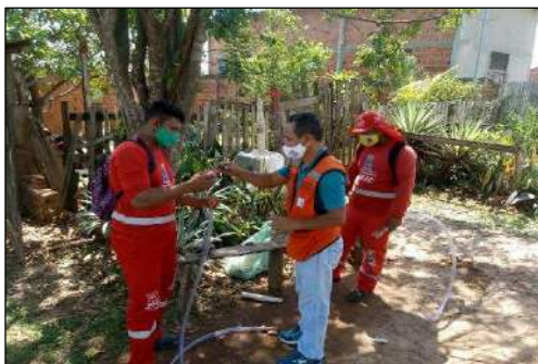
Preparação e colocação das conexões da tubulação da caixa d'água
