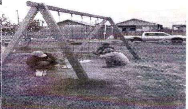
foto 130 – reforma e pintura do parquinho
