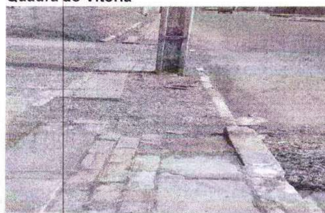
Foto 45 – calçada antes da reforma
