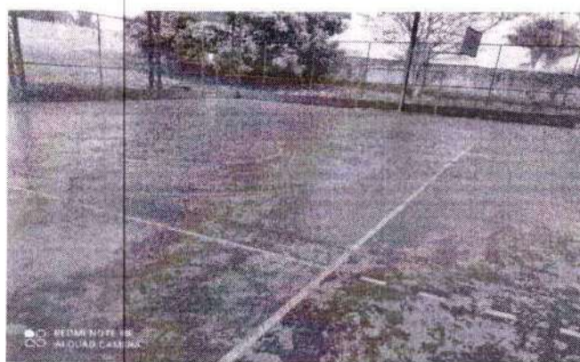
Foto 49 – poste e mureta do quadro antes da reforma
