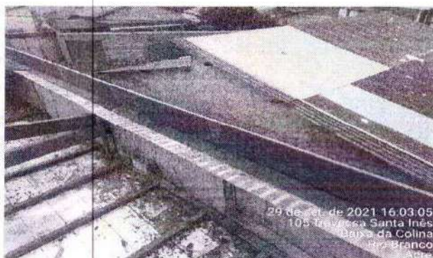
Foto 06 - Telhamento Com Telha De Fibrocimento (Arquivo Seinfra)
