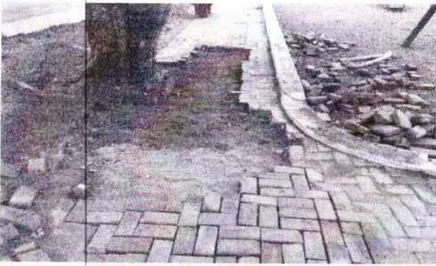
Foto 67 – calçada antes da reforma
