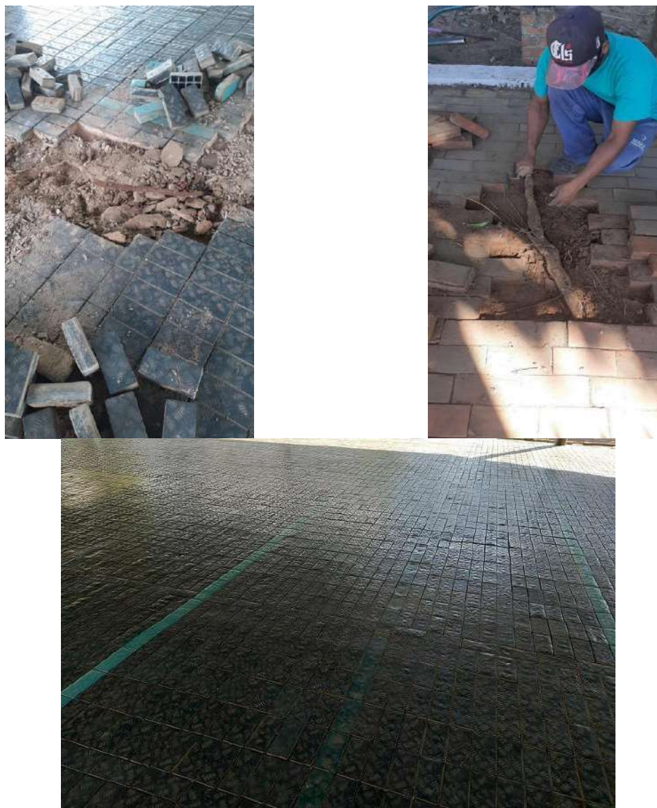
Figura 114. Retirada de raízes no galpão e pista de tijolos
