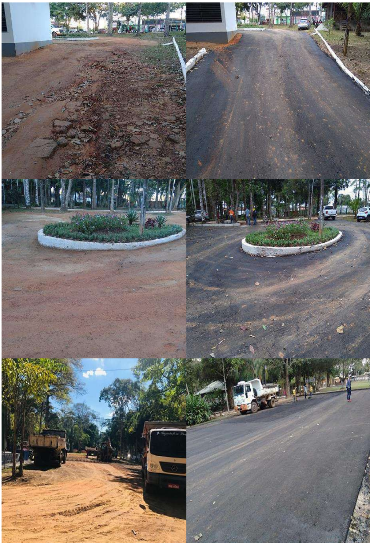
Figura 110. Pavimentação asfáltica na pista central do horto florestal
