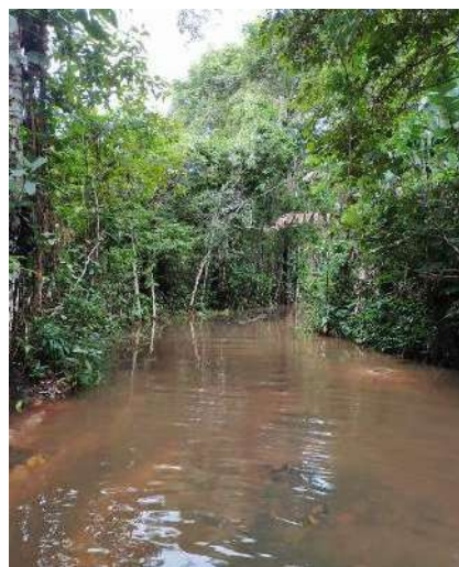
Figura 123. Registro do problema grave de drenagem em vários pontos da ciclovia
