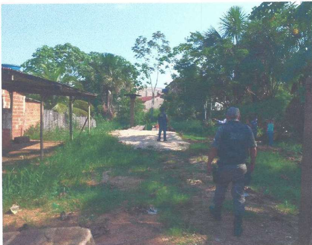
Imagem 07: Policiamento Ostensivo para demolição em área de preservação permanente.
