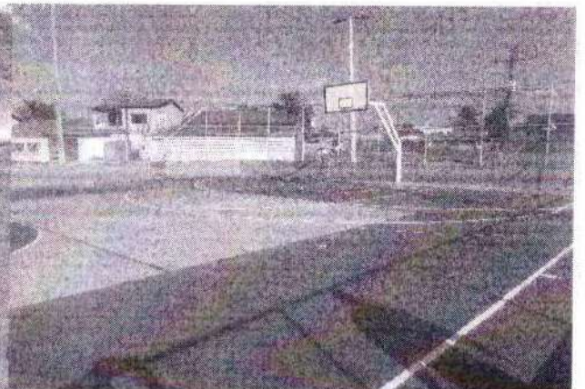
foto 34 – execução do alambrado e pintura
