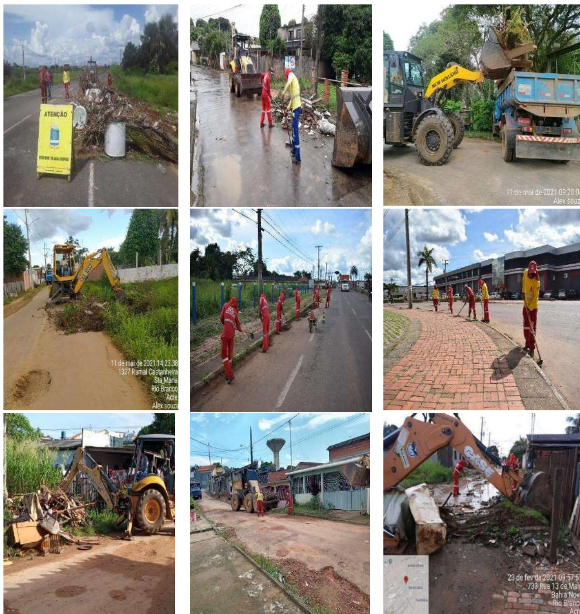
Figura 6 – Serviço de capina e retirada de entulhos
