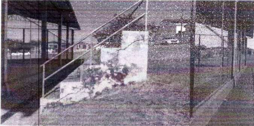
Foto 81 – Arquibancada Antes Da Reforma
