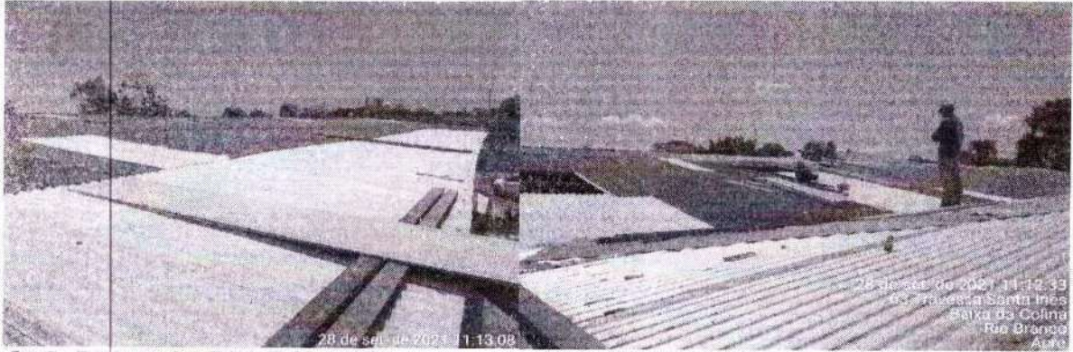
Foto 7 – Telhamento Com Telhas De Fibrocimento
