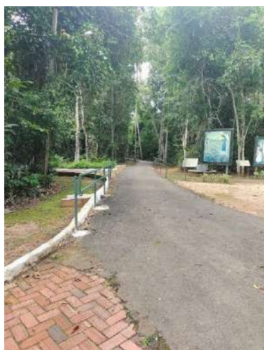
Figura 128. Registro da instalação do corrimão guia, que tem por objetivo facilitar a mobilidade de cadeirantes e deficientes visuais
