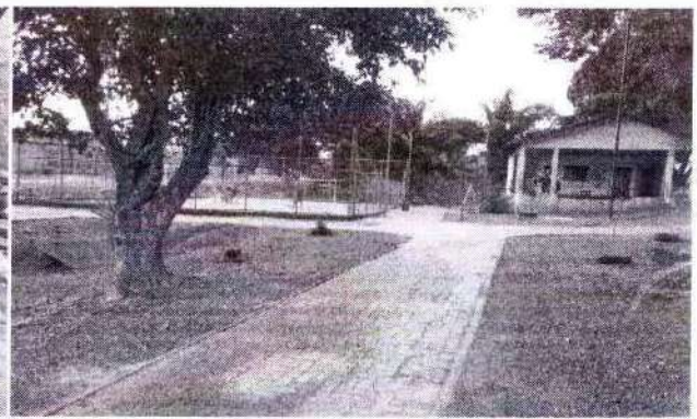
foto 68 – execução da calçada
