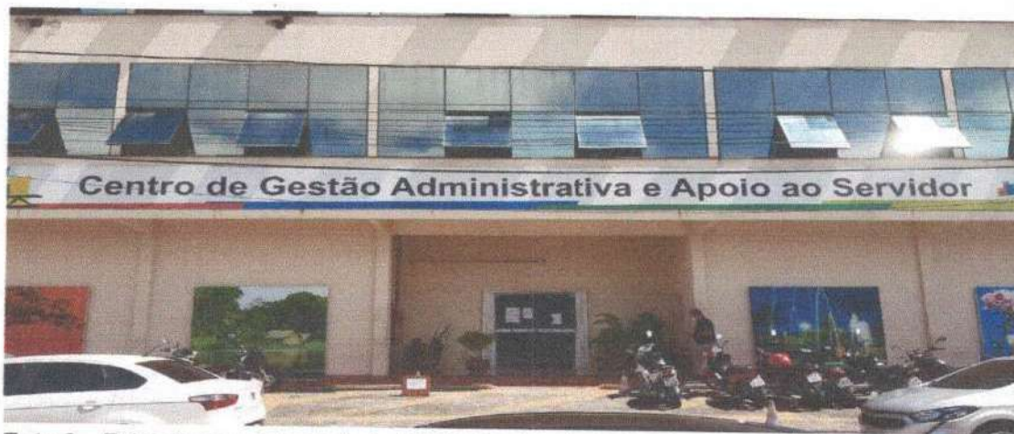
Foto 6 – Faixada do prédio sede da SEGATI antes da reforma
