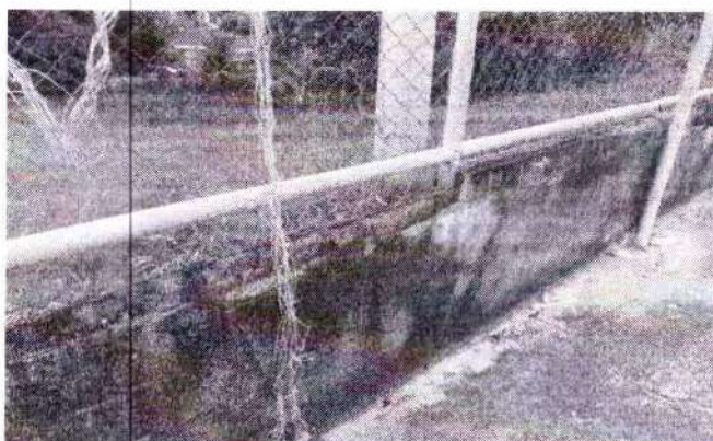
Foto 107 –mureta da quadra antes da reforma
