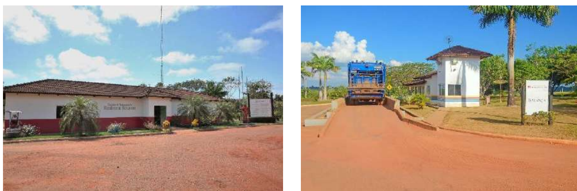
Figura 139. Estruturas da Unidade de Tratamento e Disposição Final de Resíduos Sólidos
