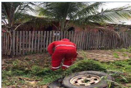
Limpeza no local de instalação da caixa d'água
