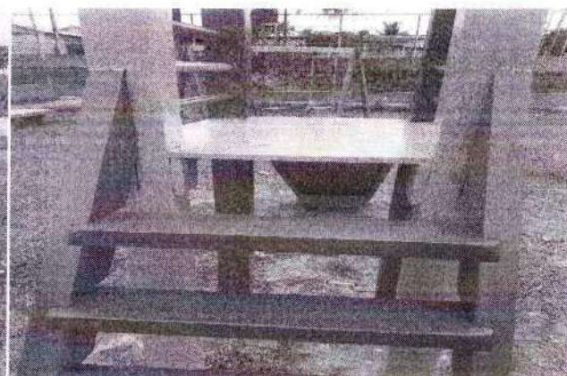
foto 128 – reforma e pintura do parque
