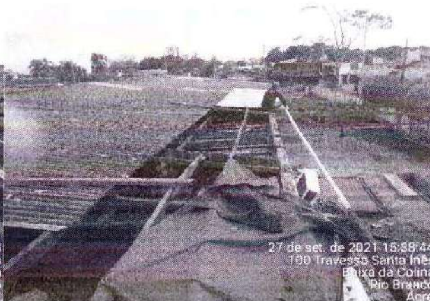
Foto 04 - Execução De Trama De Madeira (Arquivo Seinfra)
