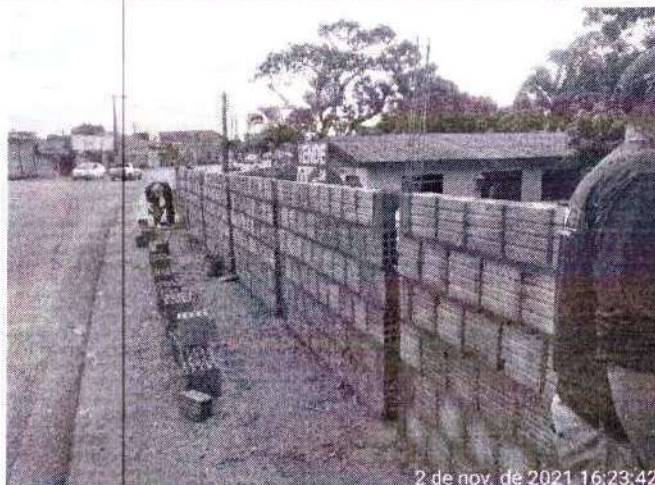
foto 29 -30- execução de alvenaria (muro)
