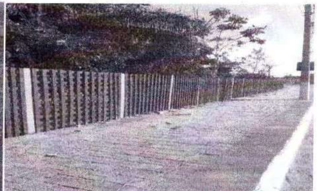
foto 134 – execução e pintura da cerca
