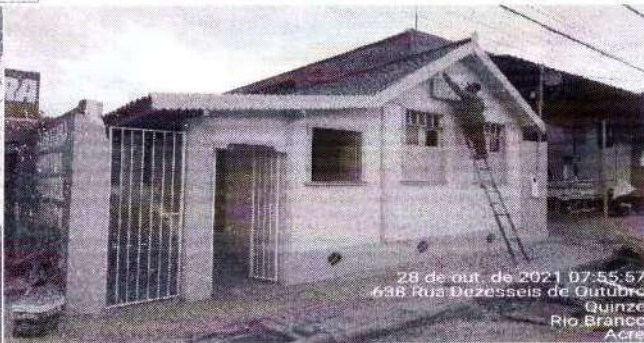
foto 20 - pintura de paredes de madeira (centro cultural Nenem Sombra)
