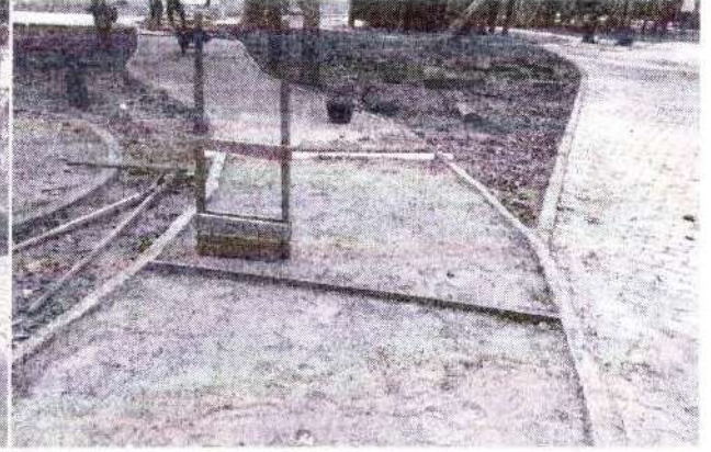
foto 52 – execução e pintura da calçada
