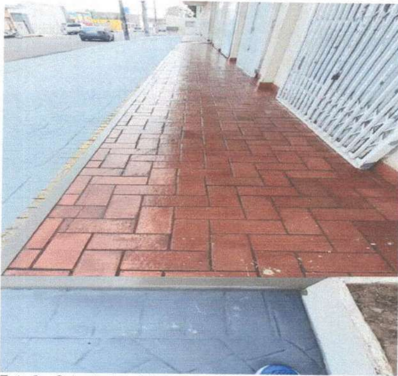
Foto 9 – Calçada do prédio sede da SEGATI após reforma
