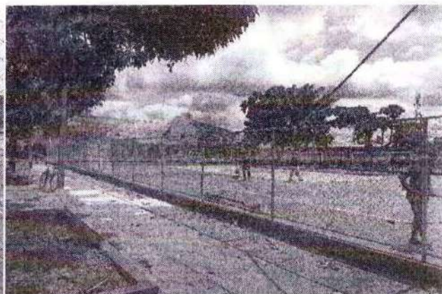
foto 96 - execução da reforma do alambrado
