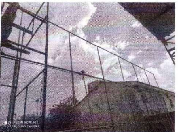
foto 92 – execução da reforma do alambrado
