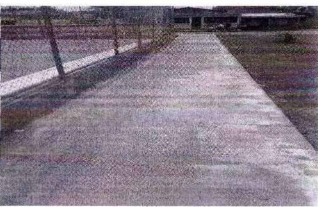
foto 102 – execução da calçada
