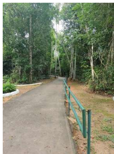
Figura 128. Registro da instalação do corrimão guia, que tem por objetivo facilitar a mobilidade de cadeirantes e deficientes visuais
