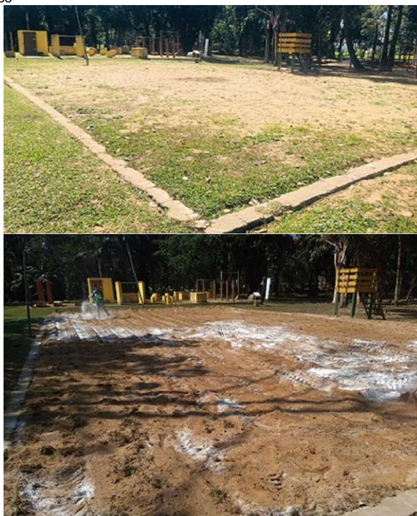
Figura 106. Quadra de areia - limpeza, desinfecção com cal virgem e reposição de areia
