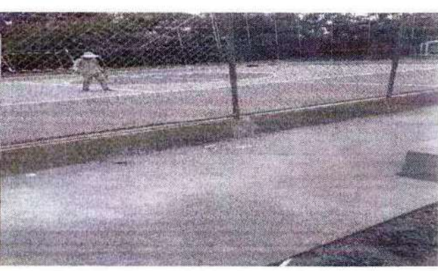
foto 104 –reforma do alambrado e da mureta
