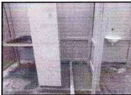
Figura 11 – Vista Frontal Banheiro Coletivo
