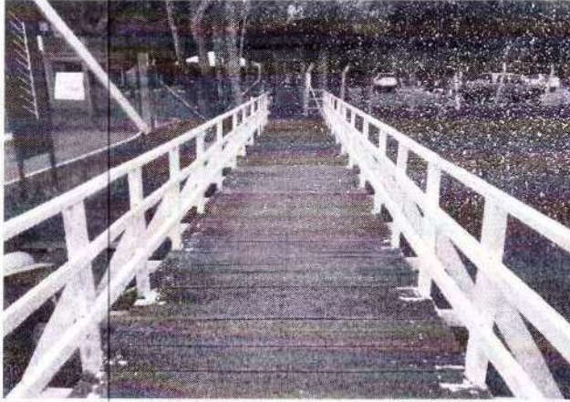
Foto 57 – execução da pintura do guarda corpo
