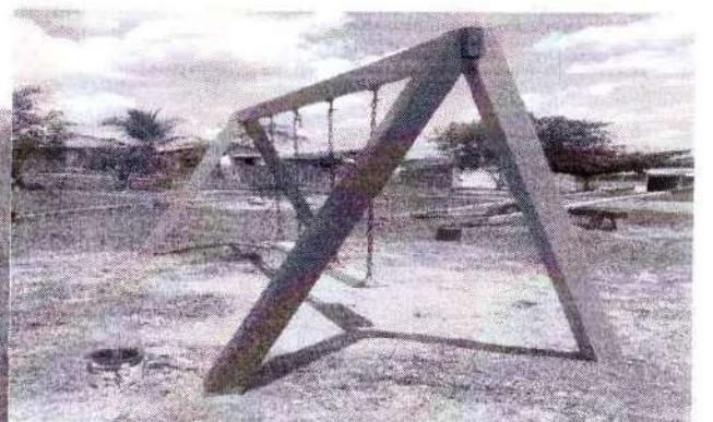
foto 122 – reforma e pintura do parquinho
