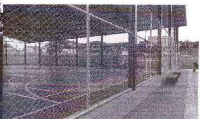
Foto 83 – quadra antes da reforma
