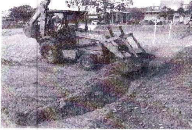
Foto 31 –regularização do campo de areia
