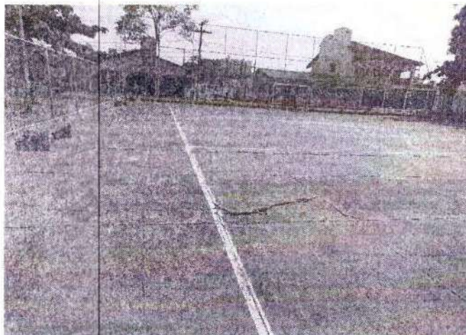
Foto 93 -quadra antes da reforma
