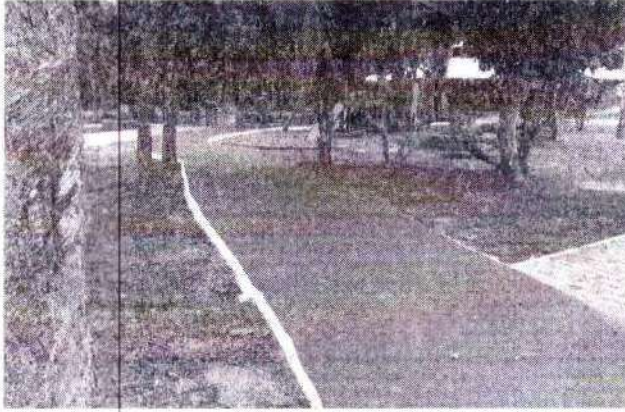
Foto 51 – execução da calçada
