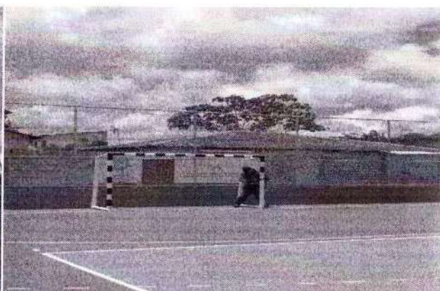
foto 110– execução da pintura da quadra
