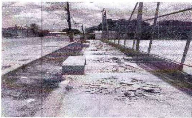
Foto 101 – calçada antes da reforma
