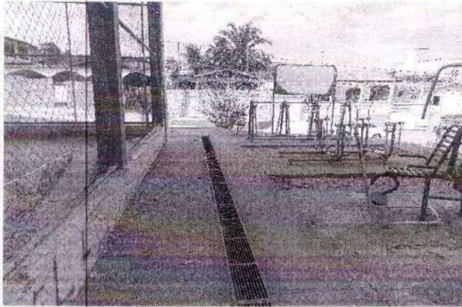
Foto 87 – piso e mureta da quadra antes da reforma
