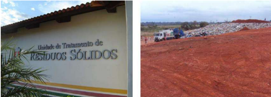
Figura 6 – Unidade de Tratamento e Destino Final de Resíduos Sólidos Urbanos (UTRE).
