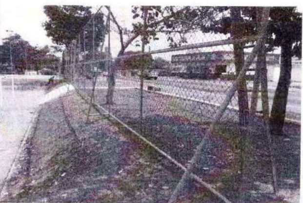
foto 28 –alambrado depois da reforma
