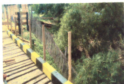
FOTO 15 - INSTALAÇÃO E PINTURA DE GUARDA CORPO
