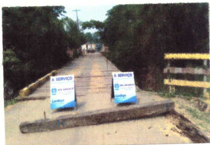
FOTO 01 - POSICIONAMENTO DOS CAVALETES DE SINALIZAÇÃO
