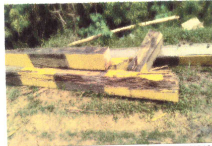
FOTO 02 - DEMOLIÇÃO E REMOÇÃO DE PEÇAS DANIFICADAS (GUARDA-RODA)
