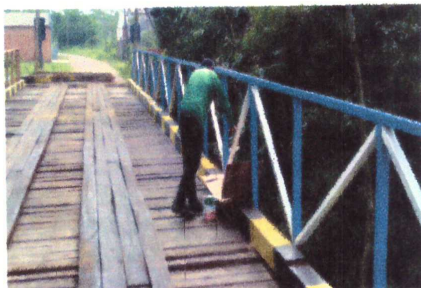
FOTO 17 - INSTALAÇÃO E PINTURA DE GUARDA CORPO
