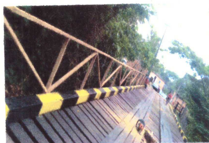
FOTO 16 - INSTALAÇÃO E PINTURA DE GUARDA CORPO
