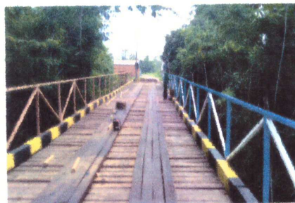
FOTO 18 - INSTALAÇÃO E PINTURA DE GUARDA CORPO
