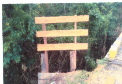
FOTO 20 - INSTALAÇÃO DE SINALIZAÇÃO
