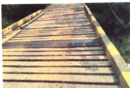
FOTO 11 - ASSOALHO FINALIZADO E FIXAÇÃO DOS GUARDA RODAS
