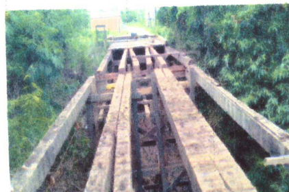
FOTO 06 - TROCA DE TRAVESSINA E BALANÇINHO
