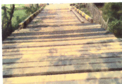
FOTO 12 - ASSOALHO FINALIZADO E FIXAÇÃO DOS GUARDA RODAS
