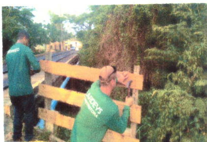
FOTO 19 - INSTALAÇÃO DE SINALIZAÇÃO
