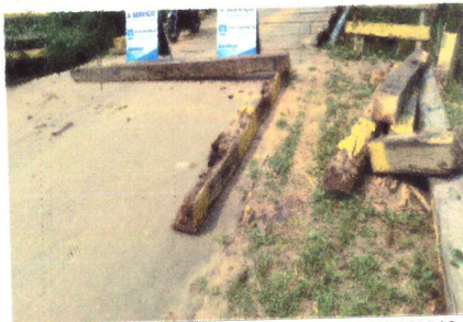
FOTO 03 - DEMOLIÇÃO E REMOÇÃO DE PEÇAS DANIFICADAS (GUARDA-RODA)
