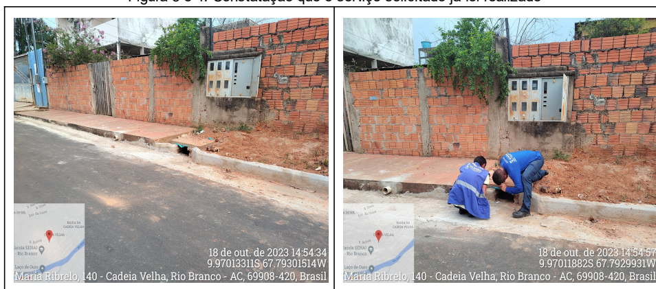
Figura 3 e 4. Constatação que o serviço solicitado já foi realizado
