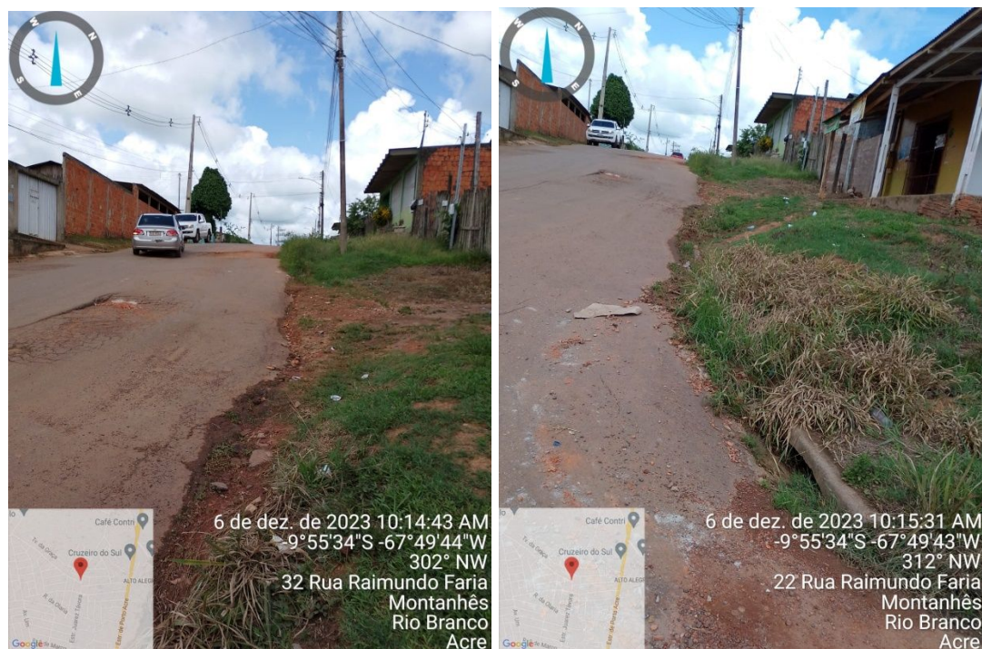
Imagem 4 – Drenagem obstruída.
