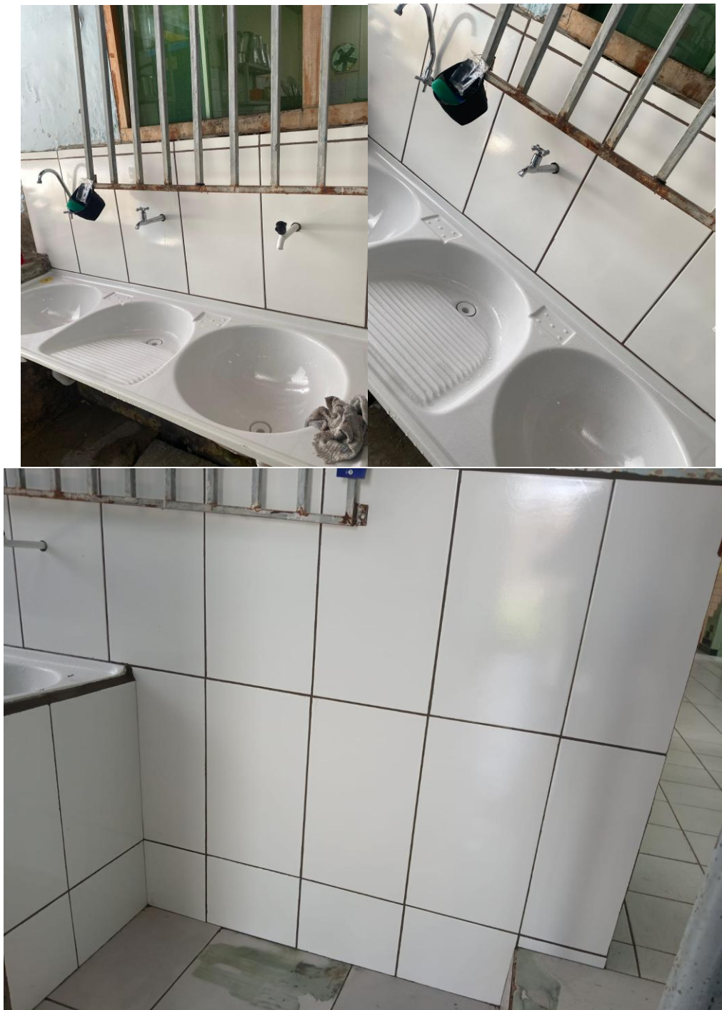
Imagens: Reforma da área de serviços (lavanderia)
