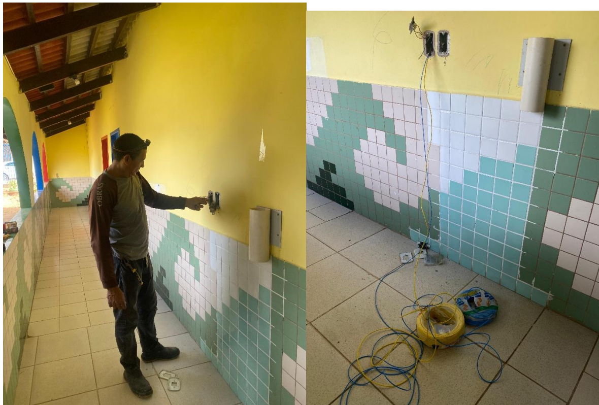
Imagens: Instalação de revestimento no corredor e troca de tomadas.
