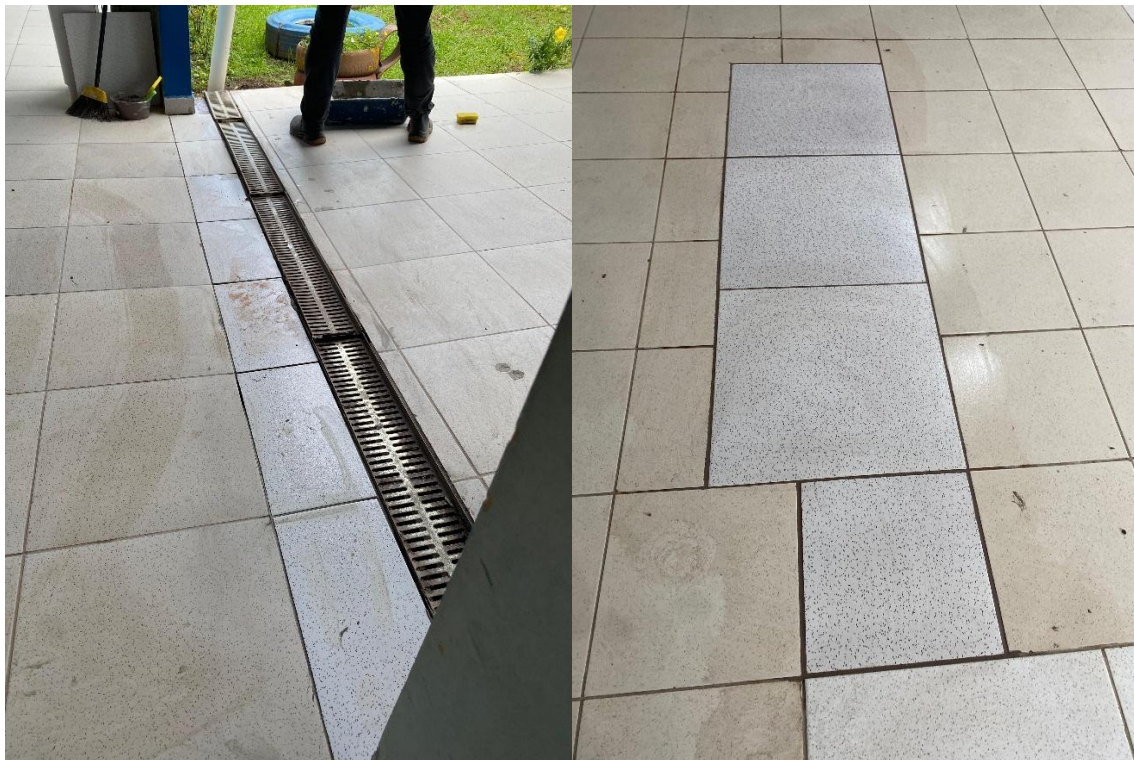
Imagens: Troca de pisos danificados.
