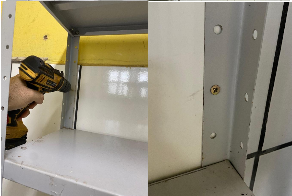
Imagens: Instalação de revestimento no depósito e instalação de prateleiras de ferro para armazenamento.
