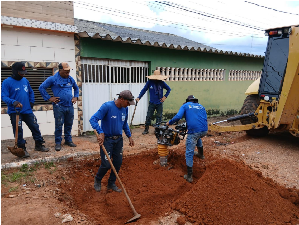
Foto 2: Aterro pós reparo da tubulação
