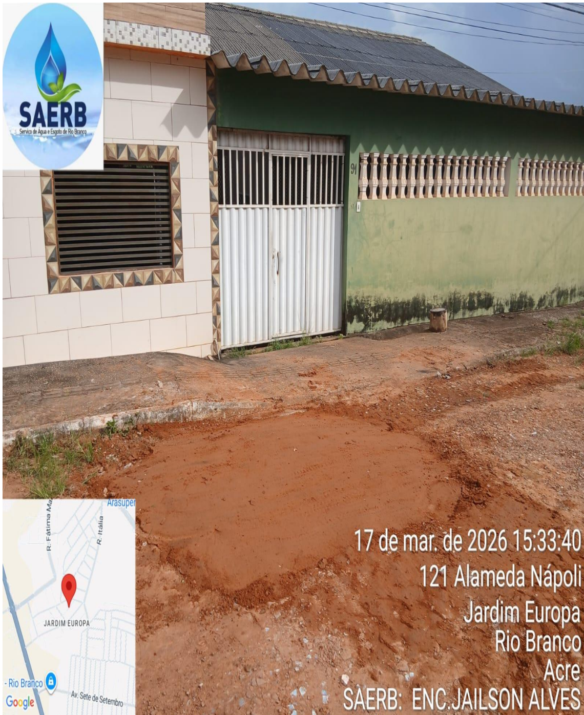
Foto 3: Serviço concluído - pós compactação mecanizada.
