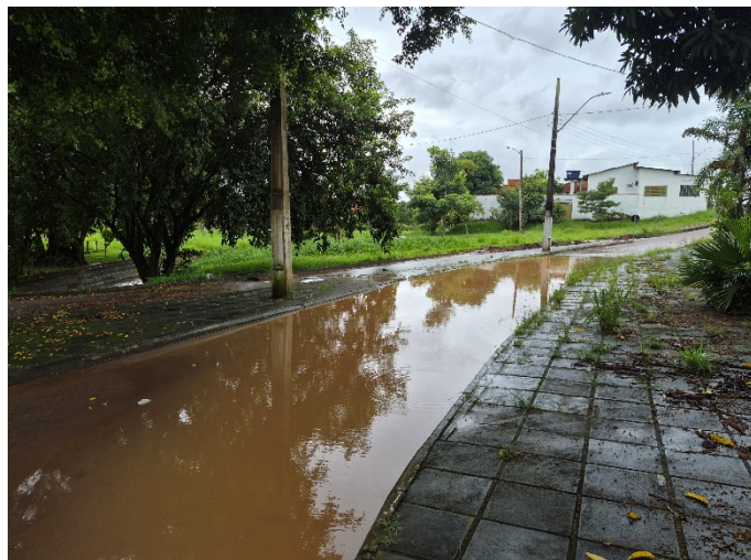
FOTO 03 – SITUAÇÃO ATUAL DA VIA
