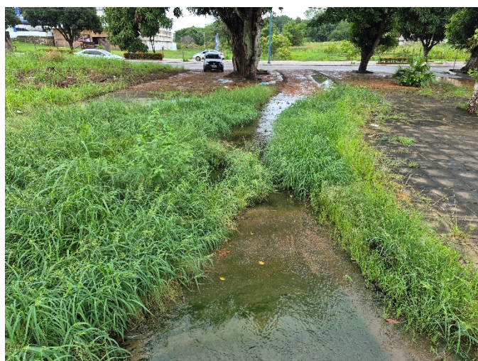
FOTO 03 – VIA COM ACUMULO DE ÁGUA E VEGETAÇÃO
