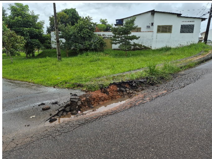
FOTO 02 – SITUAÇÃO ATUAL DA VIA
