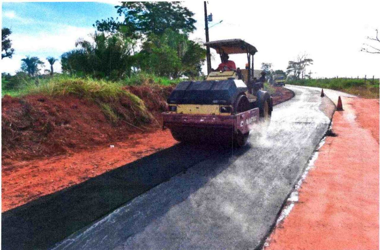
Foto 03: recuperação da Estrada do Quixadá
