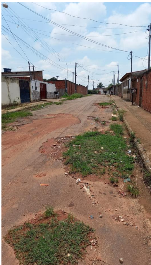
Figura 1 – Pavimentação com buracos, necessidade de limpeza e iluminação pública.
