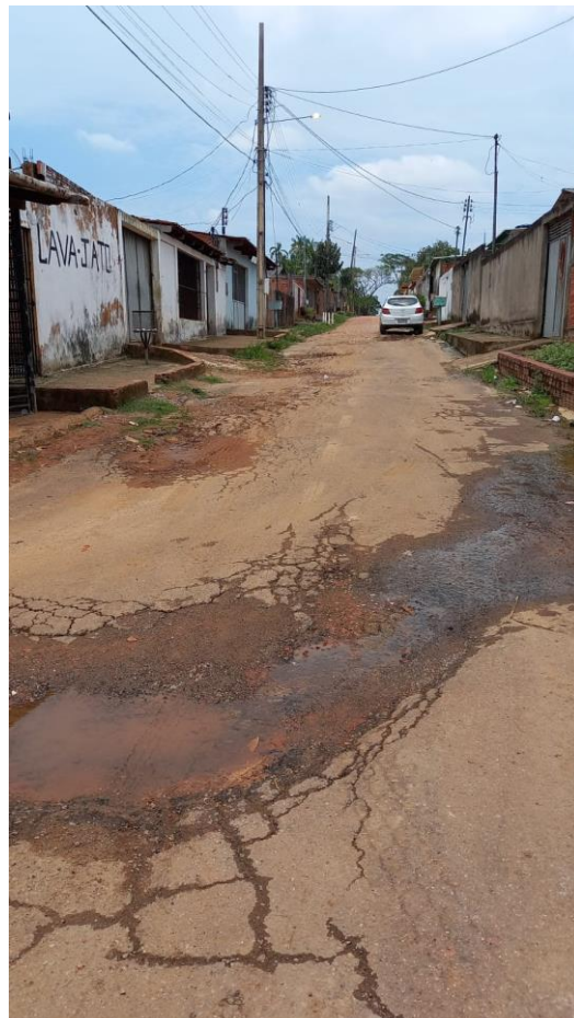
Figura 1 – Pavimentação com buracos e esgoto cheio(entupido).
