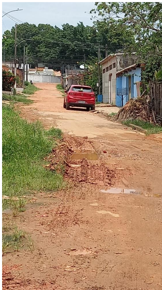
Figura 1 – Pavimentação com buracos.
