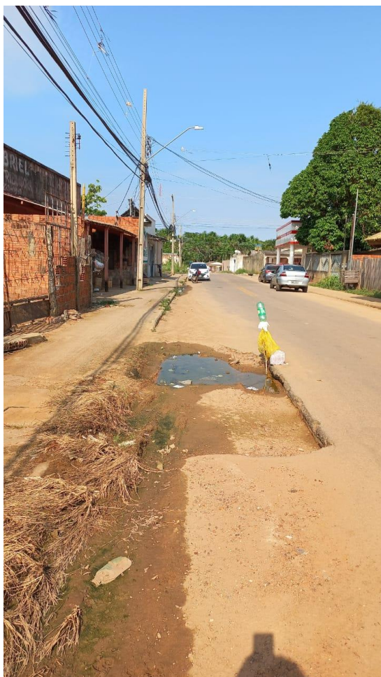
Figura 1 – Pavimentação com buracos e esgoto cheio(entupido).
