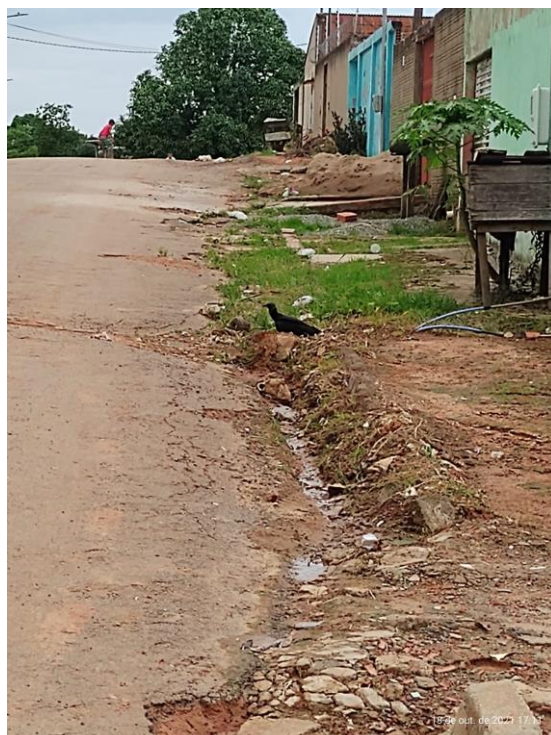
Figura 1 – Pavimentação com buracos e esgoto cheio(entupido).
