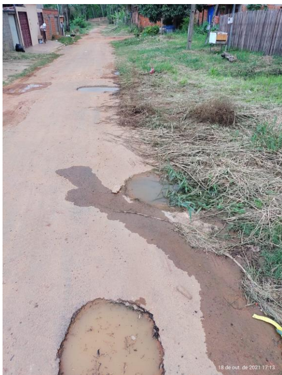
Figura 1 – Pavimentação com buracos e esgoto cheio(entupido).
