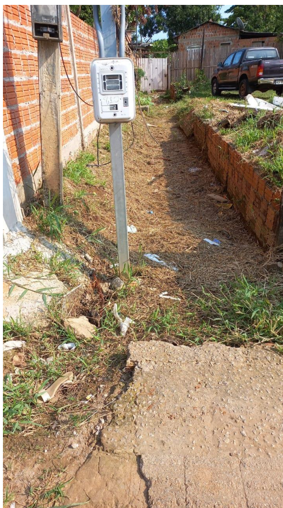
Figura 1 – Pavimentação com buracos e esgoto.
