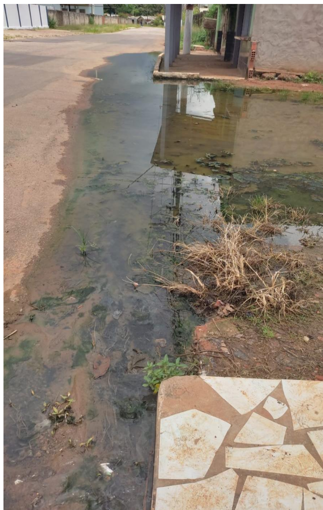
Figura 1 – Pavimentação com buracos e esgoto cheio(entupido).
