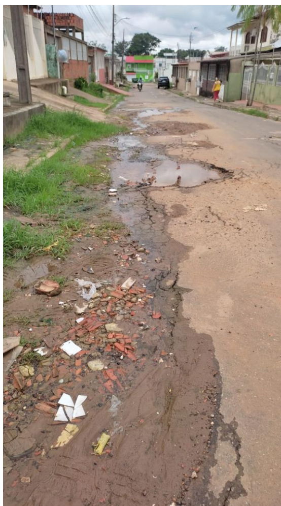
Figura 1 – Pavimentação com buracos e necessidade de limpeza.
