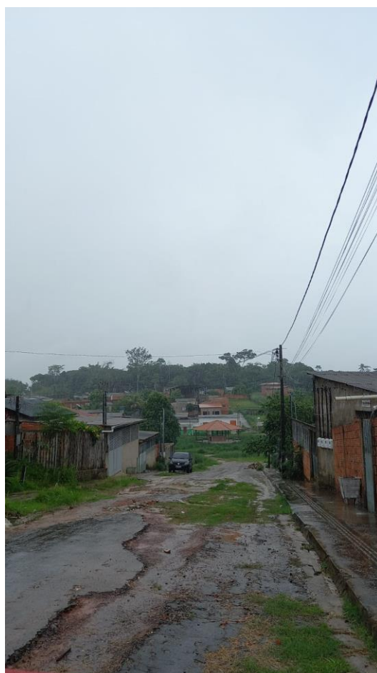
Figura 1 – Necessidade de limpeza e roçagem.
