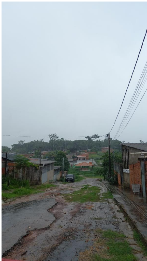
Figura 1 – Pavimentação com buracos e esgoto cheio(entupido).
