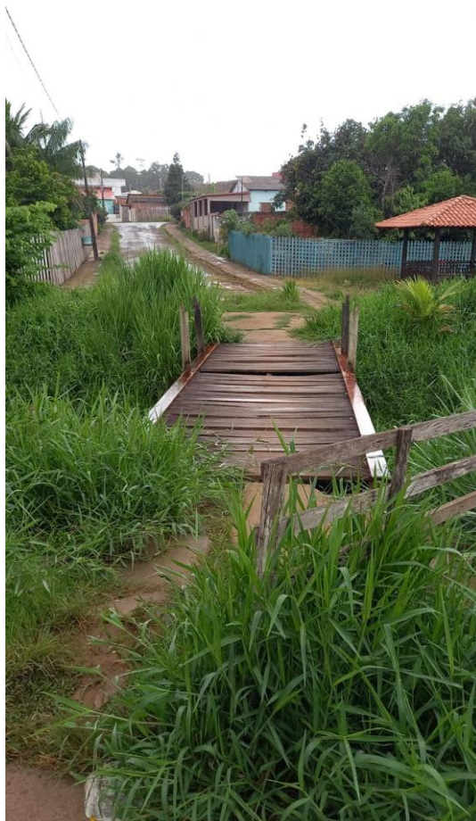
Figura 1 – Rua necessita da manutenção em sua pavimentação.
