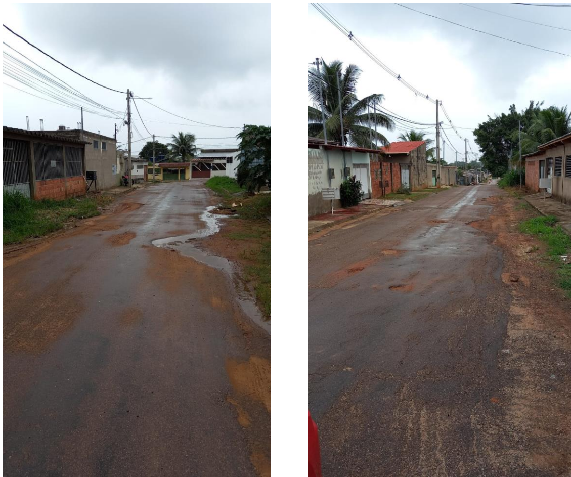
Figura 1 – Necessidade de limpeza e roçagem.
