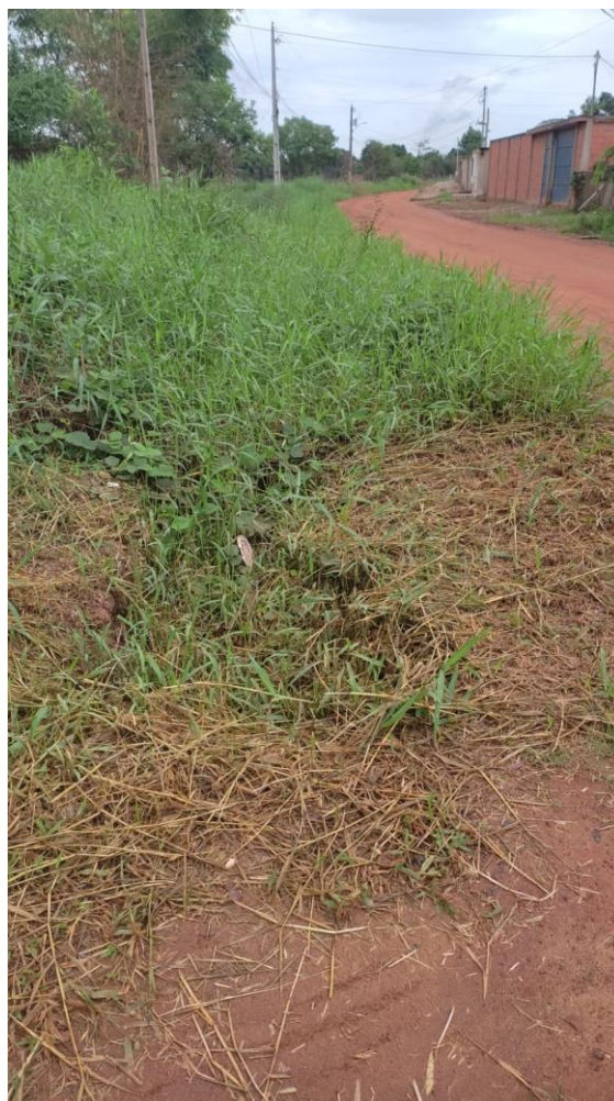
Figura 1 – Pavimentação com buracos e esgoto cheio(entupido).
