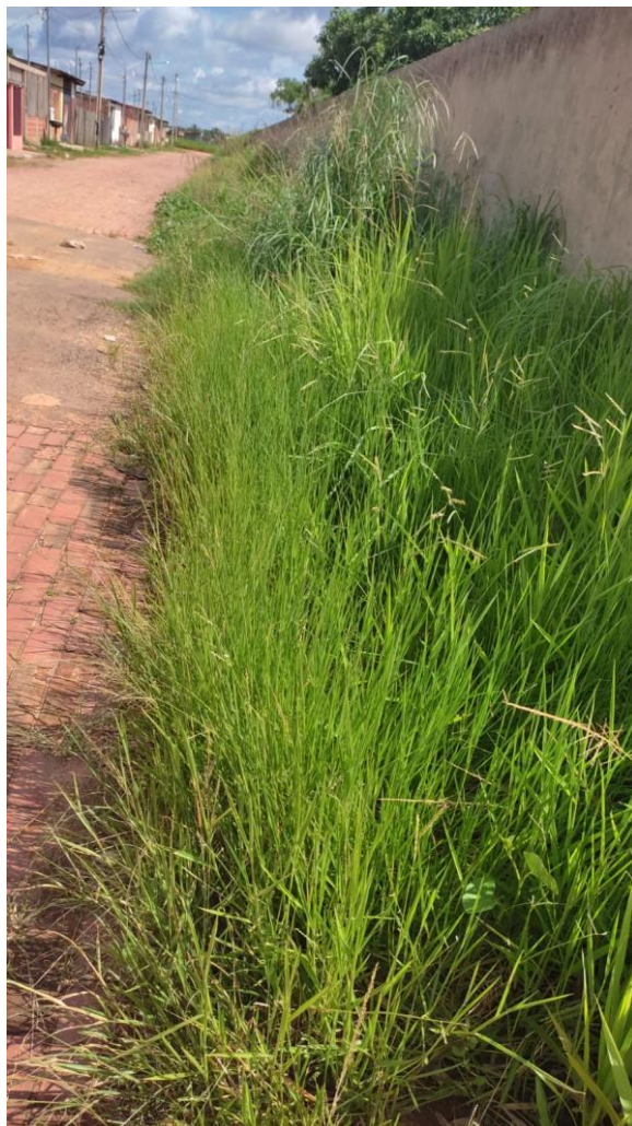
Figura 1 – Necessidade de limpeza e roçagem.
