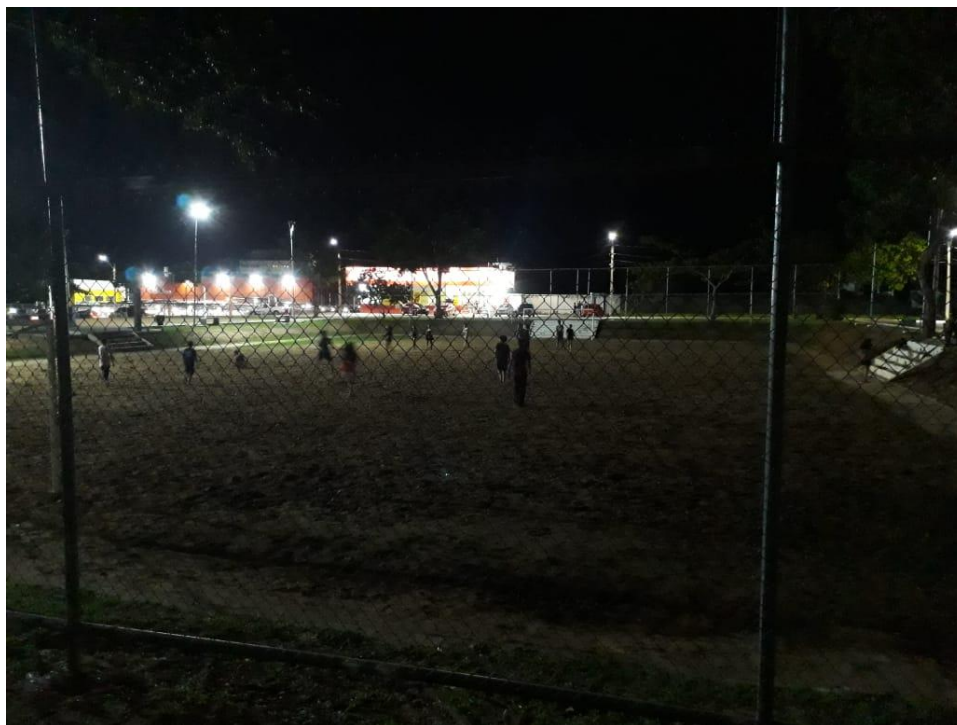
Figura 1 – Quadra e praça sem iluminação.
