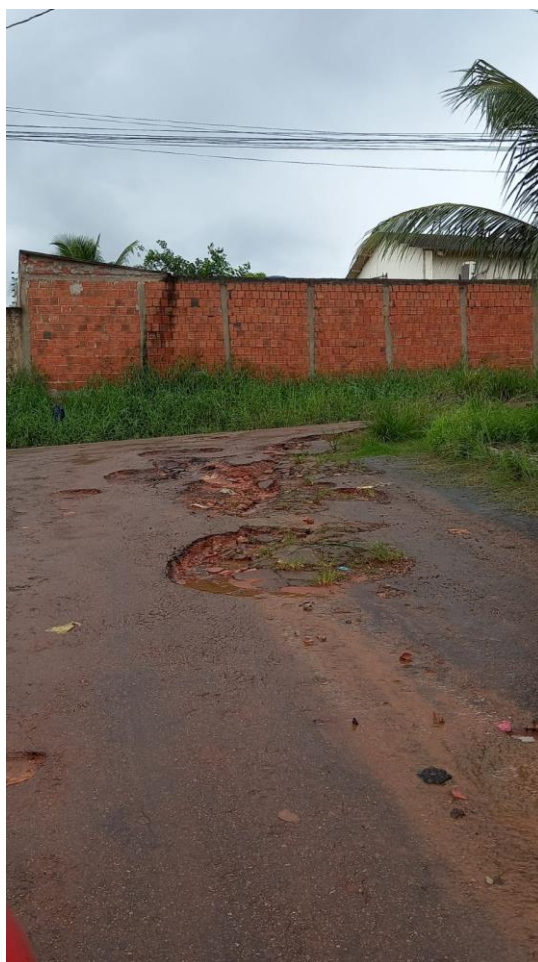
Figura 1 – Necessidade de limpeza e roçagem.
