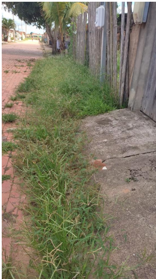
Figura 1 – Necessidade de limpeza e roçagem.
