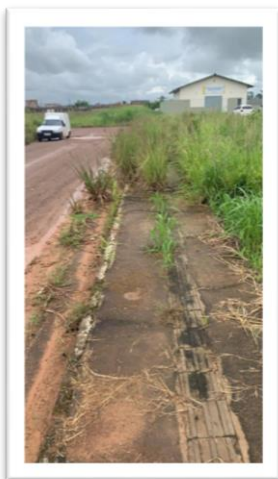
Figura 1 – Limpeza de calçadas.
