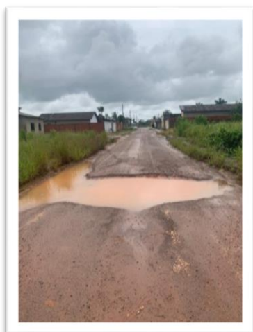
Figura 1 – Pavimentação de via pública.
