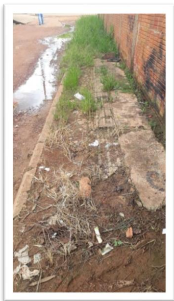
Figura 1 – Reconstrução de calçamento.
