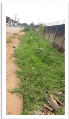
Figura 1 – Recuperação de calçadas.
