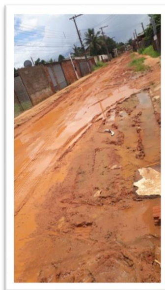
Figura 2 – Lama e buracos ao decorrer da via pública.
