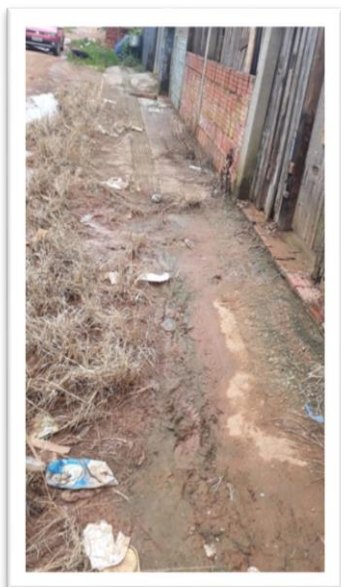
Figura 1 – Construção de calçamento.
