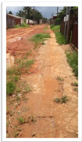
Figura 1 – Reconstrução de calçadas públicas.
