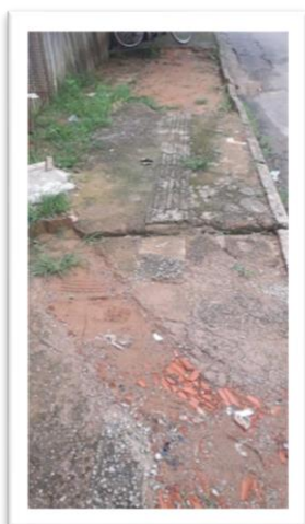
Figura 1 – Reconstrução de calçamento.
