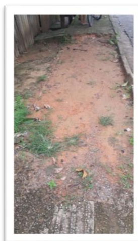
Figura 2 – Reconstrução de calçamento.
