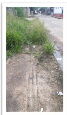
Figura 1 – Limpeza de calçadas.
