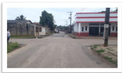
Figura 1 – Falta de sinalização em via pública.
