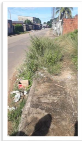
Figura 1 – Calçada coberta de mato.
