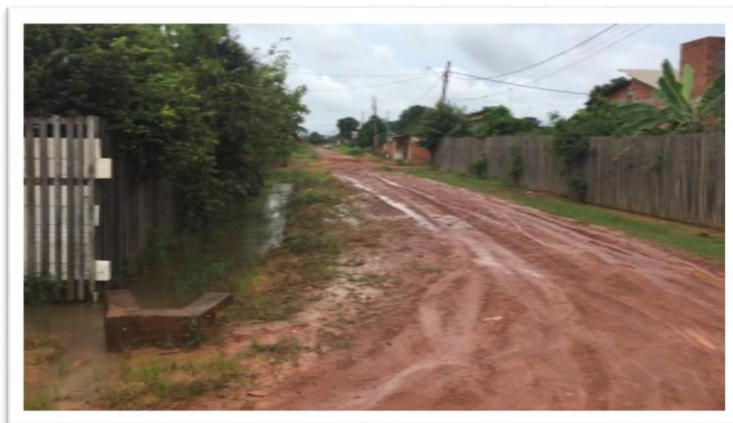
Figura 1 – Pavimentação de via pública.
