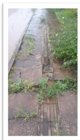
Figura 2 – Limpeza de calçada.
