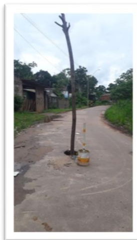
Figura 2 – Pavimentação de via pública.
