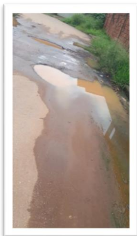
Figura 1 – Pavimentação de via pública.
