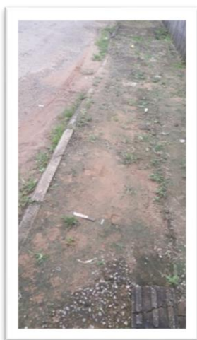
Figura 1 – Reconstrução de calçamento.
